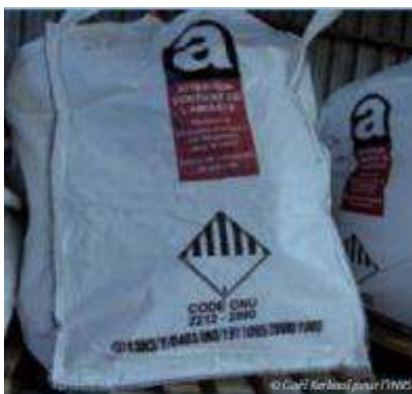
Figure 1 : Exemple d'étiquetage et de conditionnement des déchets d'amiante lié
